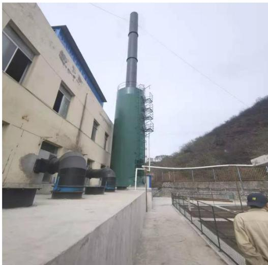
地浴式烟气净化装置+脱残塔+40m排气筒
