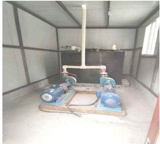
热风炉水泵房，密闭隔声
