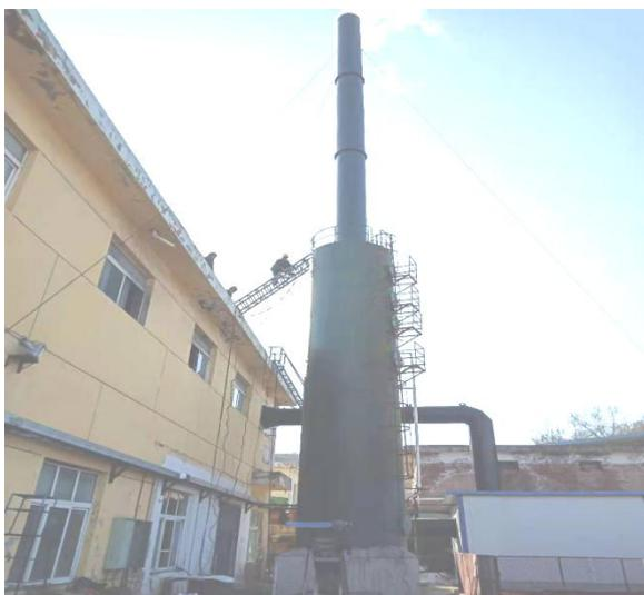
热风炉脱残塔+35m排气筒
